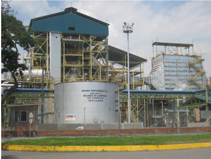
181 TPH, 67 kg/cm 2 (g), 510 Deg. C Boiler for Ingenio Providencia , Colombia
